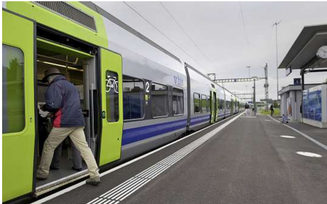
Der Bahnhof in Schmitt: Nach baulichen Hindernissen ist es geschafft und die Perrons entsprechen den neuen baulichen Massstäben. Passagiere können von jetzt an ebenerdig in die Züge einsteigen. CHARLES ELLENA
